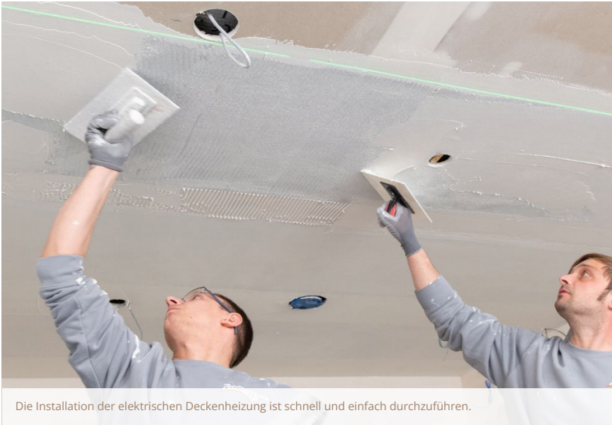
Löcher für Spots können ausgeschnitten werden.
