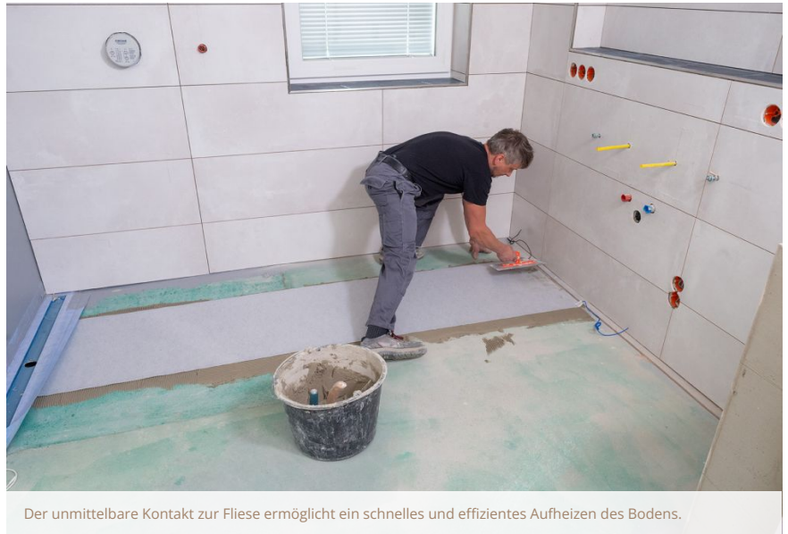
Die Heizfolie ist diffusionsoffen und haftungsoptimiert.
